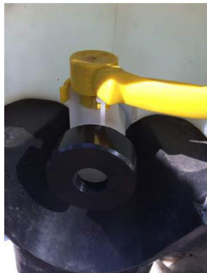
Na reducirni ventil potem lahko namestimo krogelni ventil, filter in koleno z notranjim navojem ter nadaljujemo po postopku, ki je napisan v prvih navodilih (stran 5)
